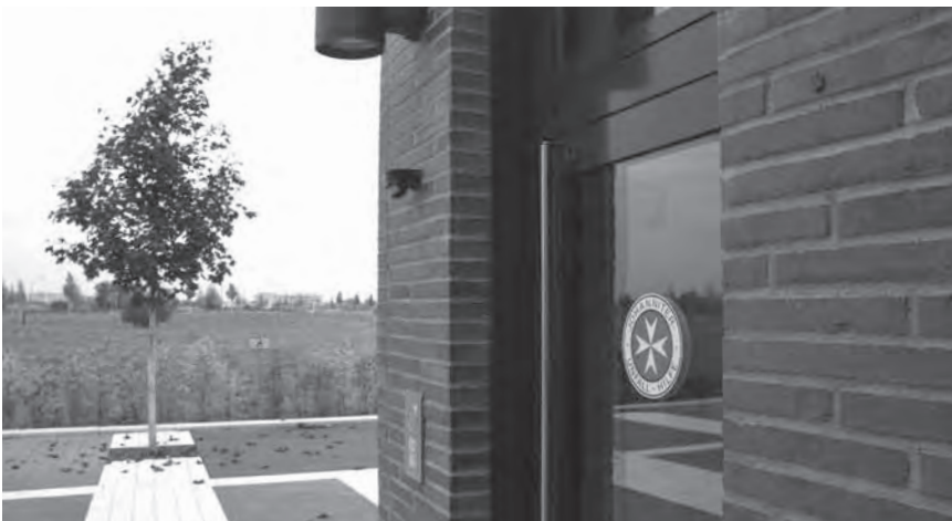
Die neu gebaute Wache in Schönefeld ist nur einen Steinwurf vom neuen Flughafen entfernt.
